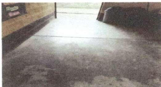
Foto 5: Fotografía de piso en mal estado que se necesita colocación de piso cerámico.
